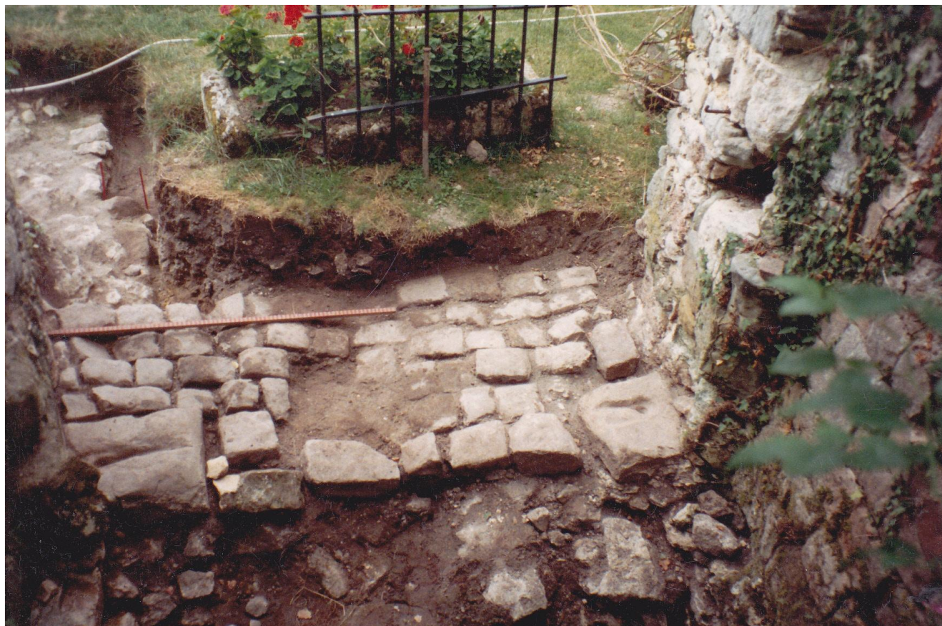
Voirie située dans le passage pratiqué entre les deux tours. A droite, au sol, une des crapaudines nécessaires aux vantaux.
